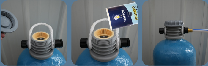
1. Remove top cap 2. Pour in salt 3. Regeneration water flow
